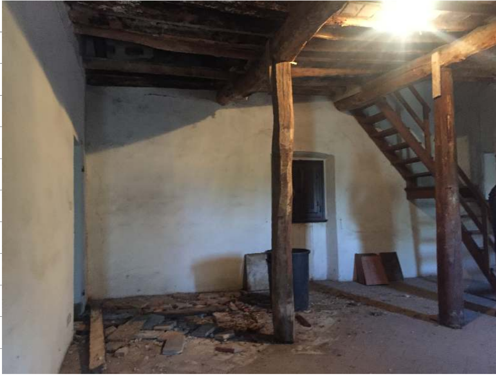
Foto 6-7 locali posti al piano terzo interessati da infiltrazioni e crolli
