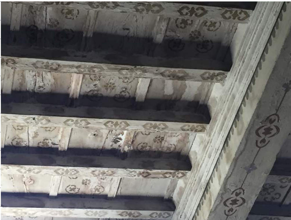
Foto 4-5 locali al piano primo interessati da infiltrazioni dal piano terzo
