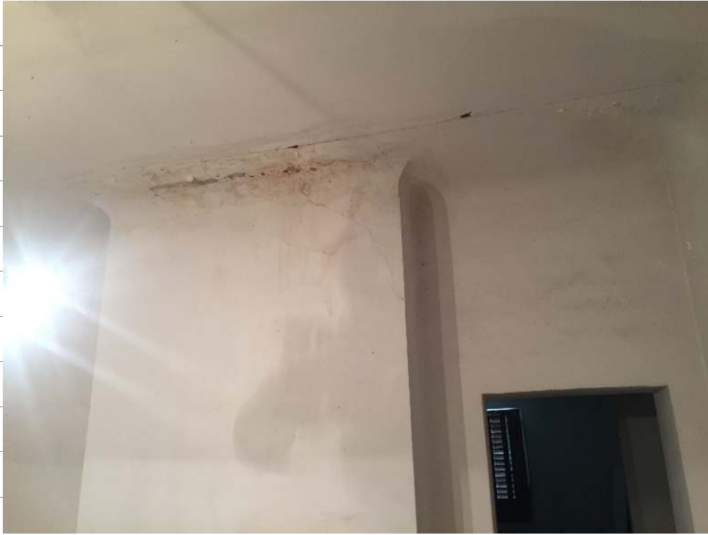
Foto 4-5 locali al piano primo interessati da infiltrazioni dal piano terzo
