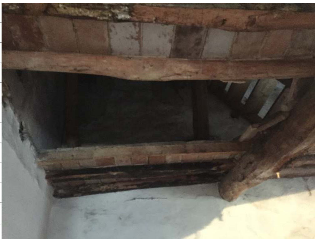
Foto 8-9 solaio tra piano terzo e quarto interessato da infiltrazioni e crolli
