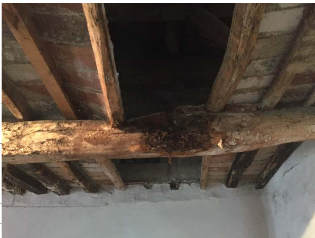
Foto 8-9 solaio tra piano terzo e quarto interessato da infiltrazioni e crolli
